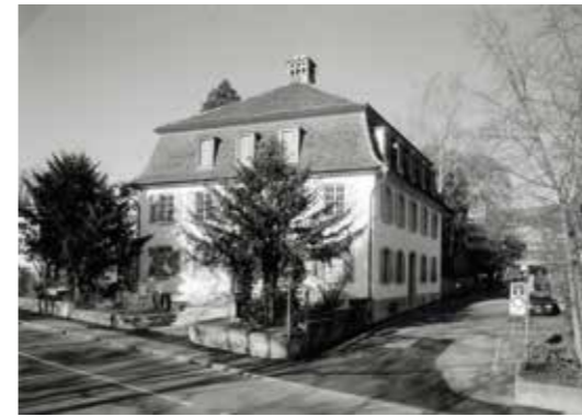
Abb. 4: Ostfassade nach der Restaurierung. Foto: Castor Huser, Baden
