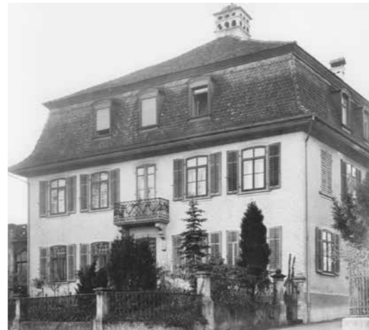
Abb. 1: Mansardendach. Zustand um 1910. Biberschwanzziegeldach mit eingemörtelten Gräten. Foto: Bürgerhaus im Kanton Aargau, S. 97
