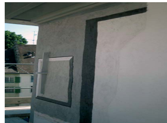
Abb. 6: Zustand der Eckquader und der Begleitbänder nach der Restaurierung. Foto: Link & Link, Scherz
