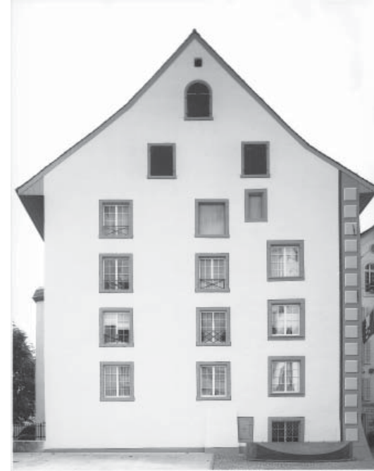
Abb. 4: Nordfassade. Zustand nach der Restaurierung Foto: Kantonale Denkmalpflege Aargau
