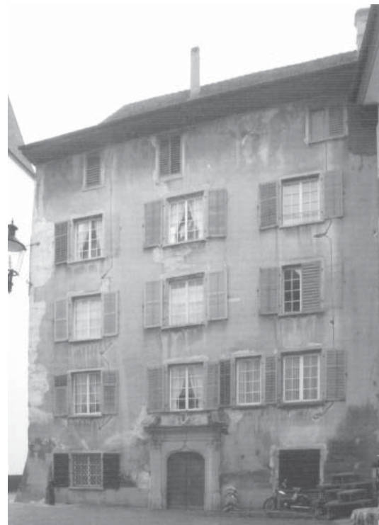
Abb. 2: Westfassade. Zustand vor der Restaurierung Foto: Kantonale Denkmalpflege Aargau
