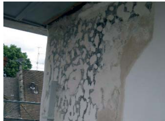
Abb. 3: Zustand der Eckquadermalerei und der Begleitbänder während der Restaurierung. Foto: Link & Link, Scherz
