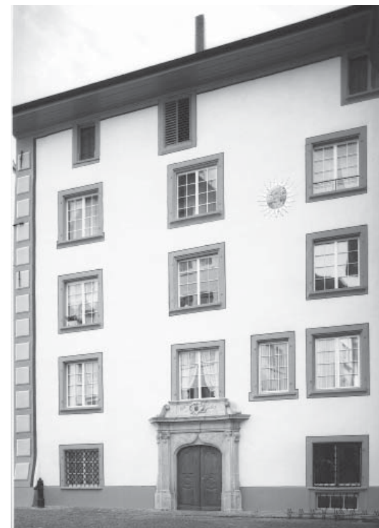
Abb. 5: Westfassade. Zustand nach der Restaurierung Foto: Kantonale Denkmalpflege Aargau
