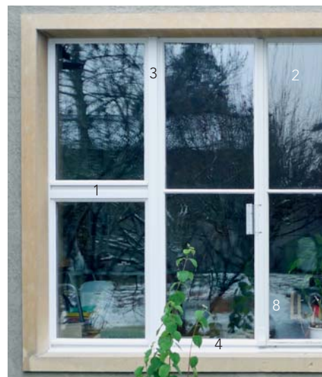
Abb. 7: Musterfenster. Ersatz der linken und mittleren Innengläser durch innere IV-Verglasung.
