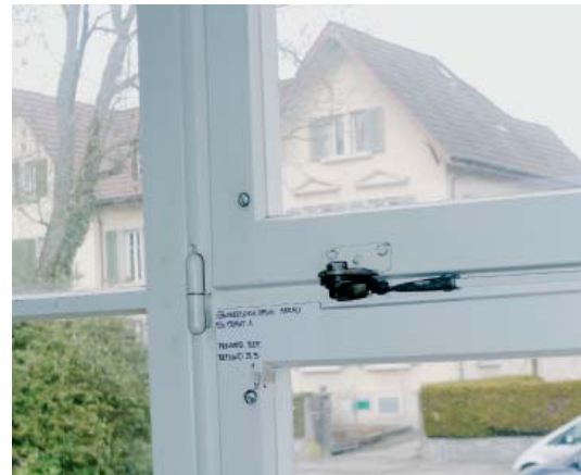
Abb. 5: Restauratorische Farbuntersuchung. Trakt 1, Erdgeschoss, Erschliessungsbereich.
