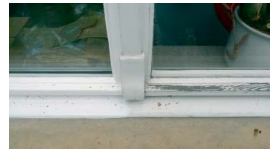
Abb. 6: Musterfenster. Linker Flügel mit IV-Glas. Rechter Flügel mit DV-Fenster. Trakt 1, Erdgeschoss, Erschliessungsbereich.
