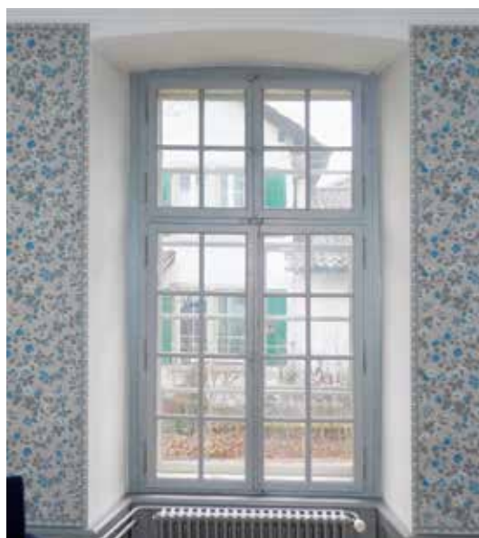
Abb. 2: Konserviertes Innenfenster. Südfassade, Erdgeschoss, Raum Nr. 11.
