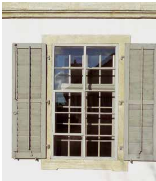
Abb. 1: Rekonstruiertes Vorfenster. Südfassade, Erdgeschoss, Raum Nr. 11.
